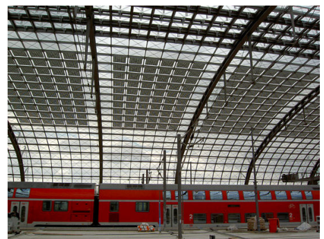
△ 태양광 전지판 설치되고 있는 중앙역의 유리 지붕
