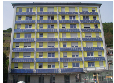
△ 벽면에 태양광발전시설이 설치된 기숙사 건물
