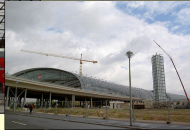
△ 태양광 전지판 설치되고 있는 중앙역의 유리 지붕 (좌) △ 2006년 완공을 목표로 공사중인 중앙역 지붕에는 태양광 전지판이 깔리고 있다 (우)
