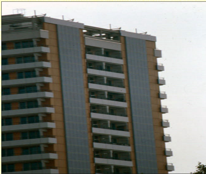
▲ 재건축한 마르찬 고층 아파트 벽면에 설치된 태양전지
