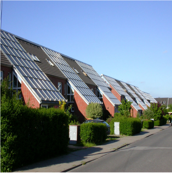
△ 주택마다 설치된 태양열 집열판
