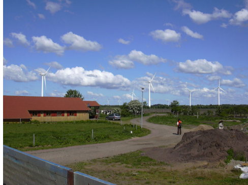
△ 농가에 설치된 풍력발전소
