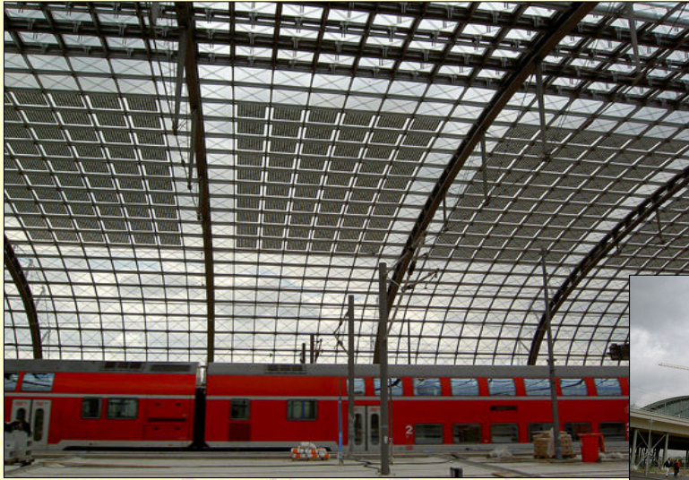
△ 태양광 전지판 설치되고 있는 중앙역의 유리 지붕 (좌) △ 2006년 완공을 목표로 공사중인 중앙역 지붕에는 태양광 전지판이 깔리고 있다 (우)
