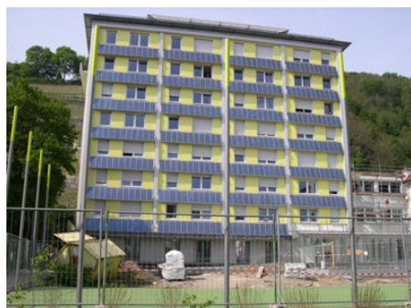
△ 태양광모듈이 설치된 카톨릭 기숙사 전경
