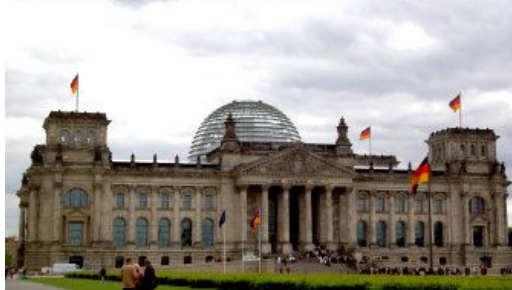
△ 채광효과를 극대화 한 연방의회 유리돔 (위). 연방의회 전경_유리 돔 앞 건물 지붕 위로 태양전지와 채광을 위한 유리천장의 구조물이 보인다.
