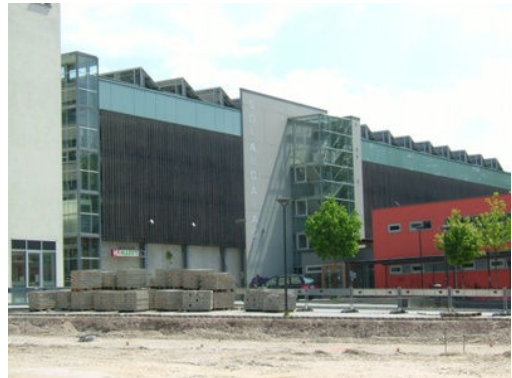
△ 보봉지구 입구에 설치된 지붕에 태양광모듈을 설치한 주차장
