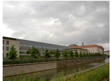
△ 태양광 전지판이 올려진 경제부 청사 지붕
